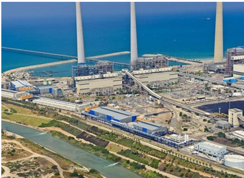
Slika 12. Prikaz postrojenja u Saudijskoj Arabiji ( najveće postojeće postrojenje) [10]
