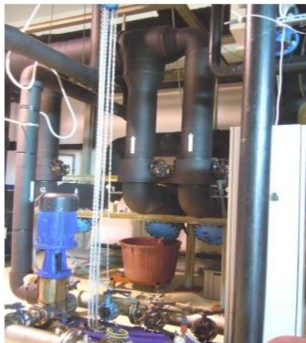
Slika 8. Sustav podizanja tlaka u pogonu [8]
