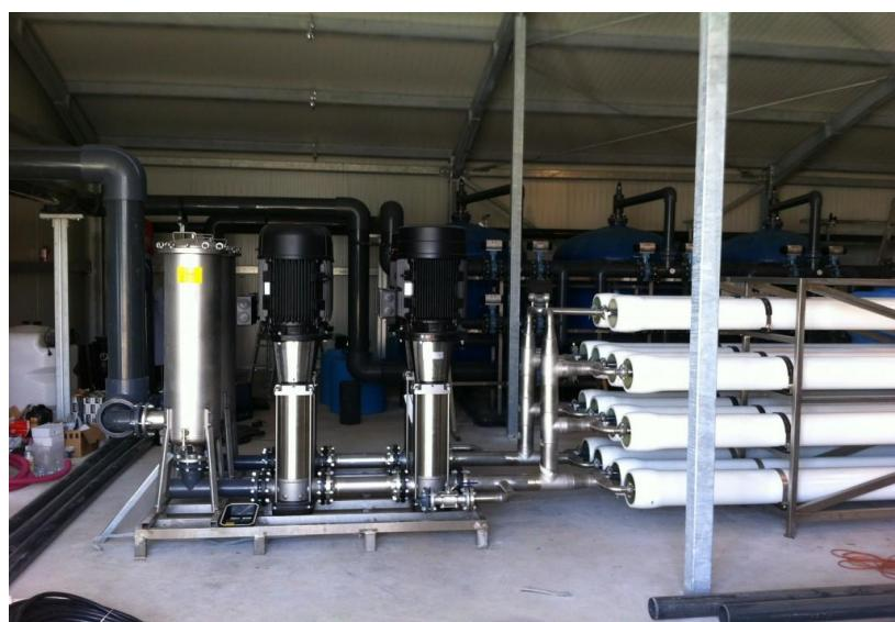
Slika 5. Postrojenje za desalinaciju boćate vode [5]
