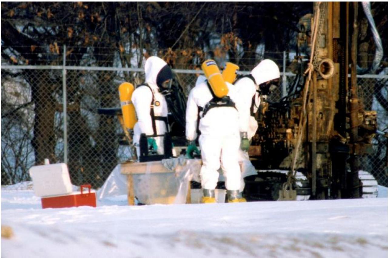
Slika 1. Bušači u zaštitnim odijelima, zaštitnim maskama i uređajima za disanje[2]
