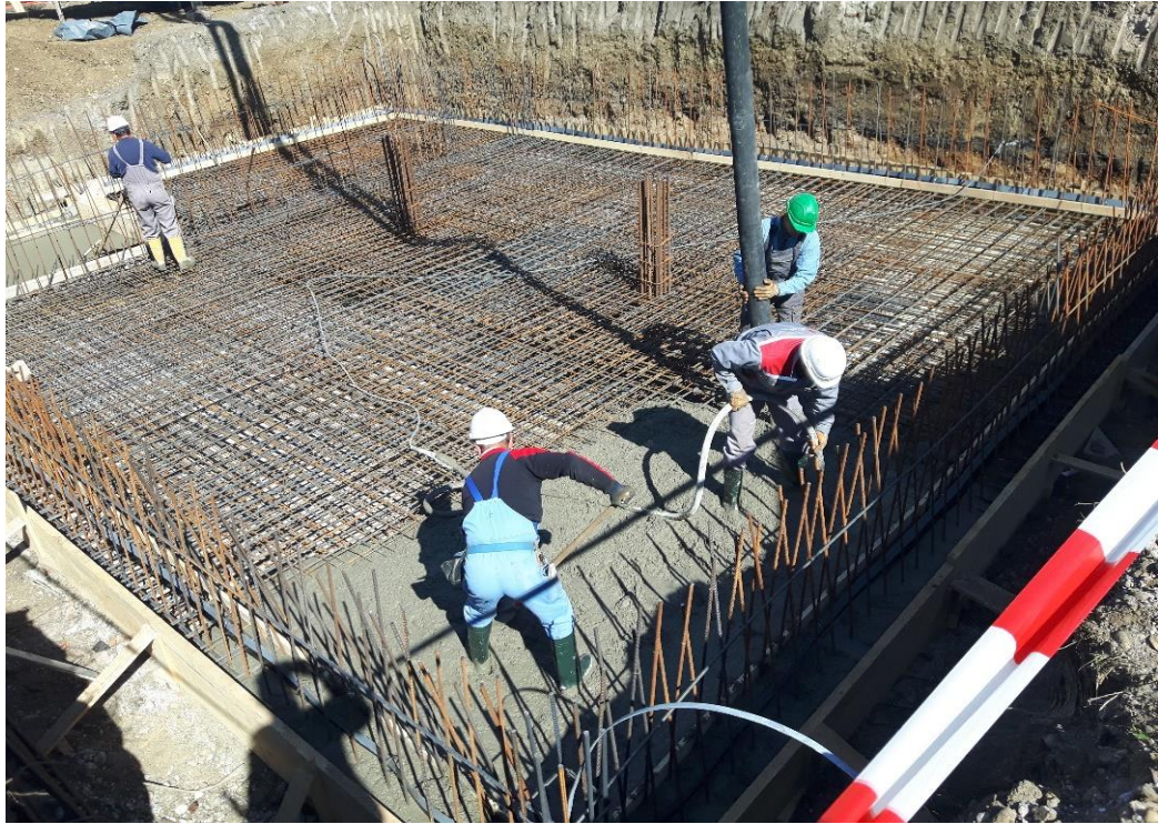
Slika 4. Betoniranje donje podložne AB ploče podruma
