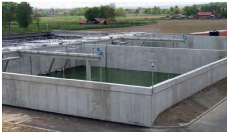
Slika 9. SB – reaktori na uređaju u Koprivnici [11]
