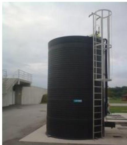
Slika 8. Tank za obradu fosfora [11]
