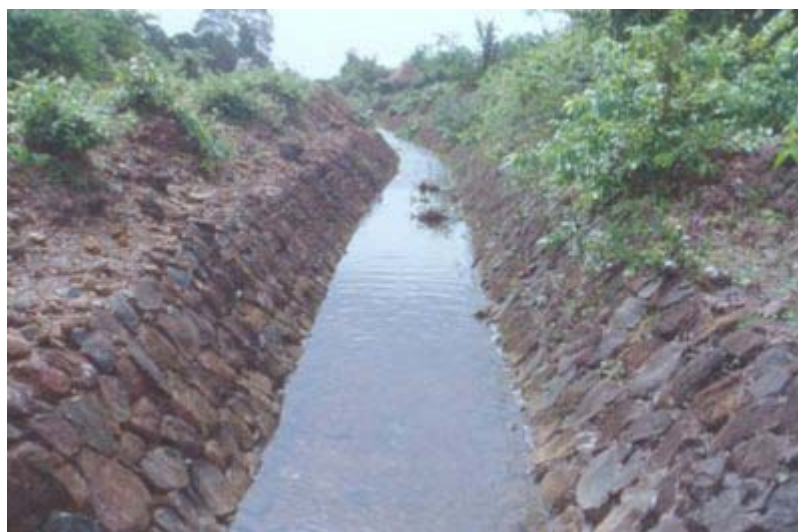
Slika 3. Kamena obloga kanala [7]
