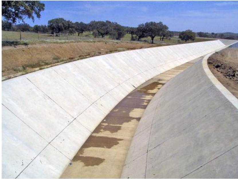
Slika 7. Betonska obloga kanala [11]
