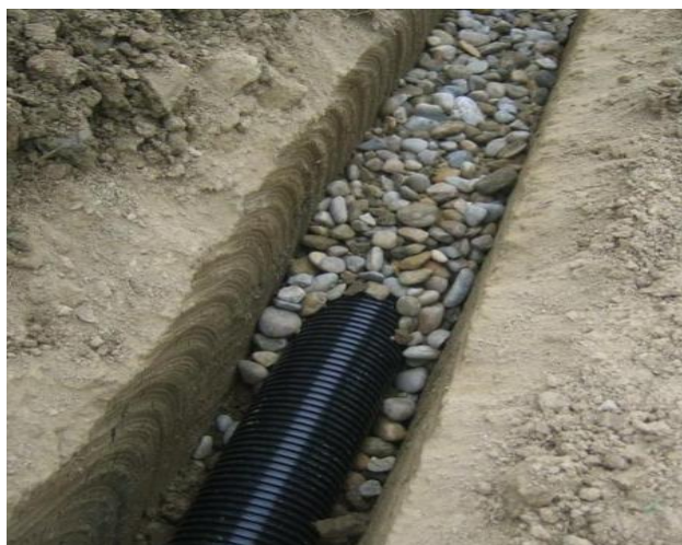
Slika 9. Drenažni sustav ( https://www.emajstor.hr/clanak/23/Drenaza_izvedba_cijena )
