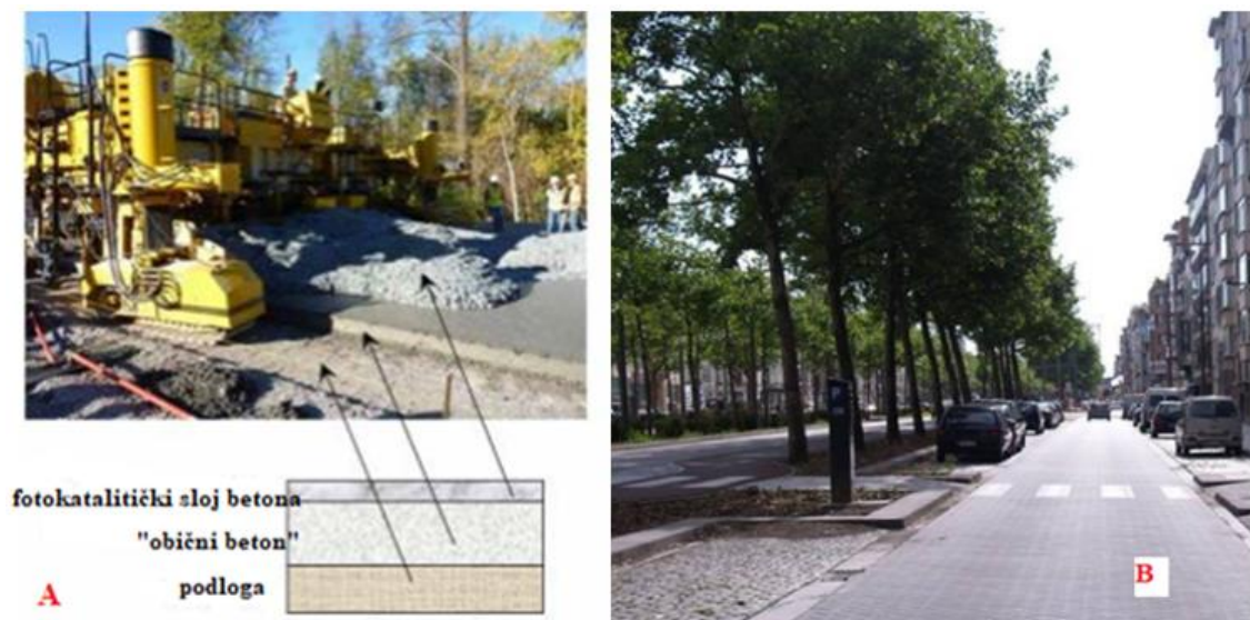
Slika 7 A) Izgradnja fotokatalitičke ceste u Louisiani (SAD); B) Fotokatalitički pločnik u Antwerpenu (Belgija) [26]
