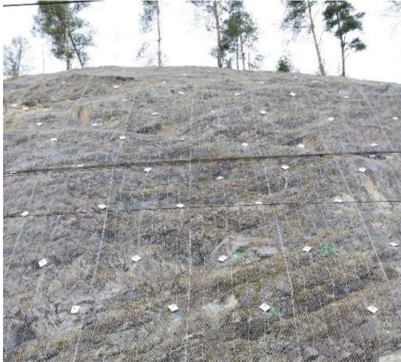
Slika 29. Primjer pokosa saniranog Steelgrid® HR sustavom
