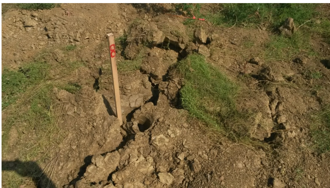
Slika 7.7 Neželjeni lijevak u obliku kratera.
