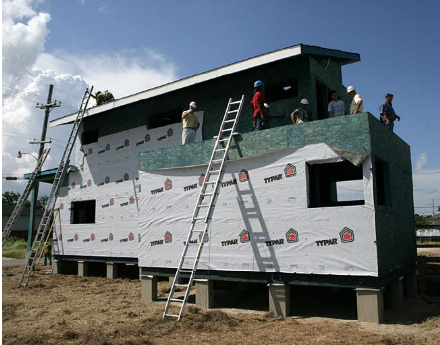
Slika 20. Prikaz kuće koja ujedinjuje mjere zaštite od poplava i mjere za izbjegavanje opterećenja [40]
