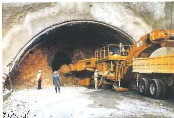
Slika 7.2. Stroj sa pokretnom glavom [5].
