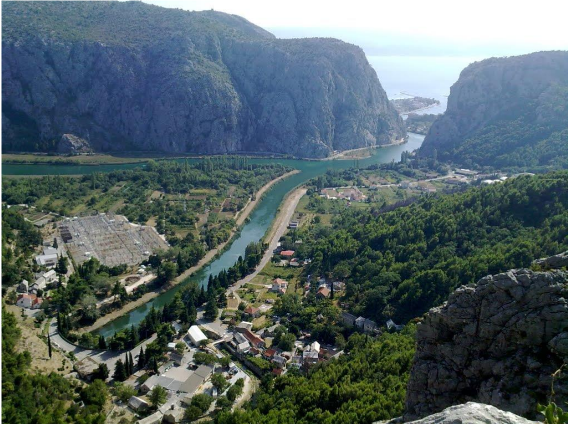
Slika 7. Hidroelektrana Zakučac (HEP.hr)
