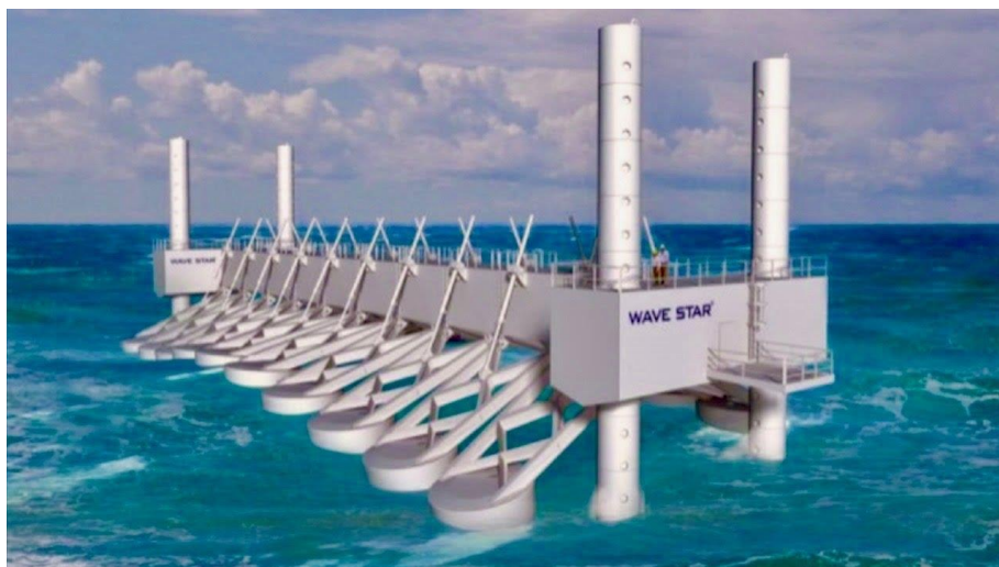
Slika 5. Sustav za pretvaranje energije valova u električnu [13]
