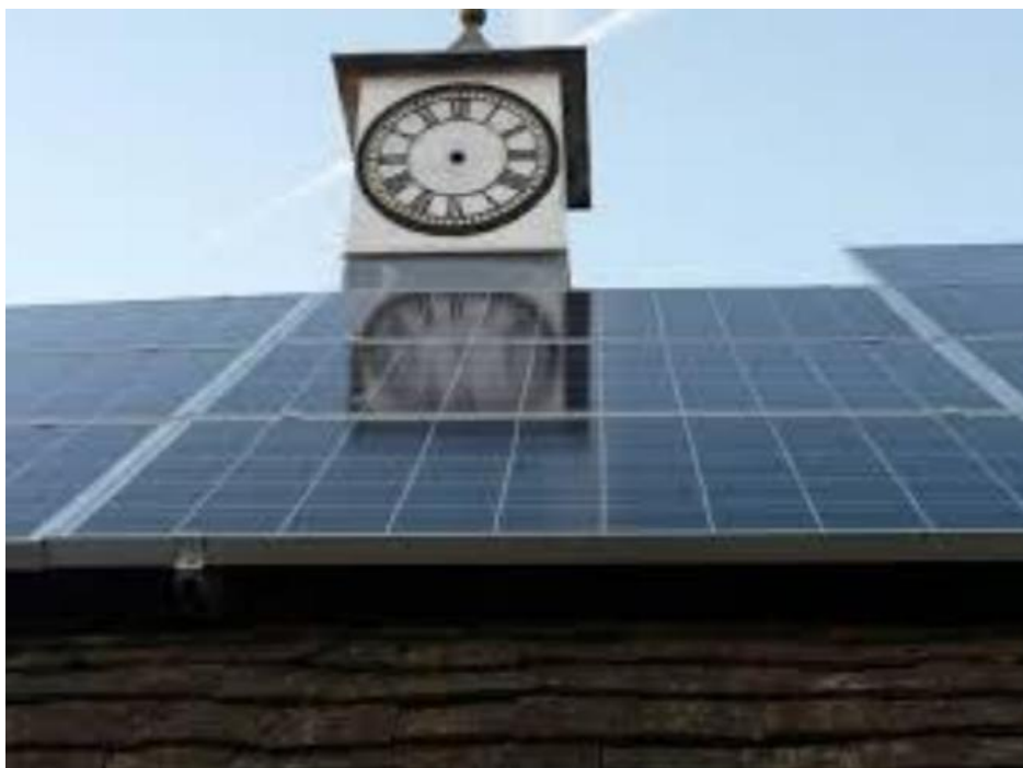
Slika 3. Zasjenjivanje fotonaponskih modula [1]
