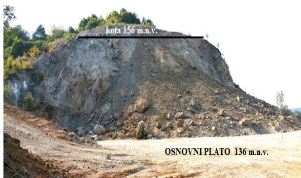
Slika 15. Kamenolom tehničko-građevnog Loskunja kod Vojnića [22]
