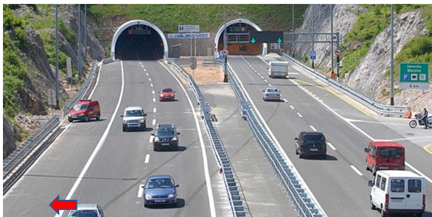
Slika 13 Zaustavni trak na autocesti [15]
