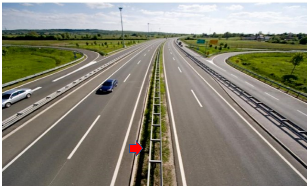
Slika 10 Rubni trak na autocesti [11]
