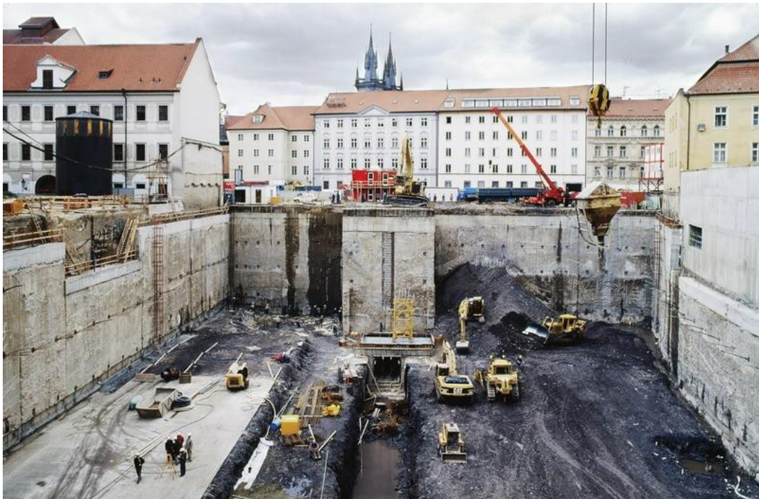
Slika 4. Armirano betonska dijafragma
