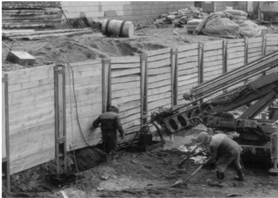
Slika 7. Zaštita berlinskim zidom od drvenih platica [2]
