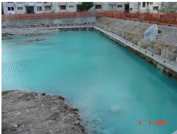
Slika 26. Prodor podzemne vode u građevinsku jamu
