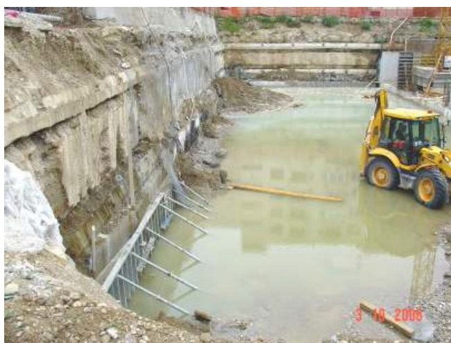
Slika 27. Izvođenje mini talpi
