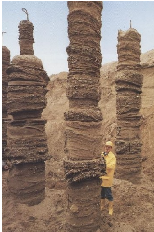
Slika 11. Stupnjaci nastali postupkom mlaznog injektiranja [6]
