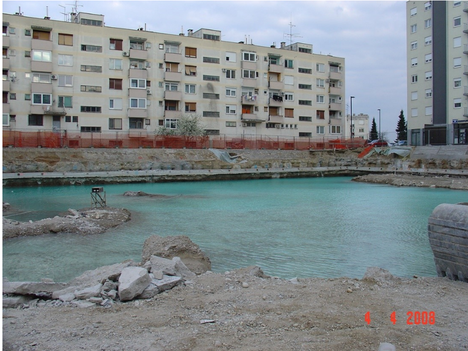
Slika 19. Neposredna blizina okolnih konstrukcija i građevinske jame
