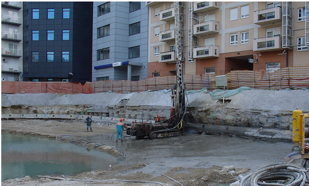
Slika 23. Mlazno injektiranje pomoću strojeva
