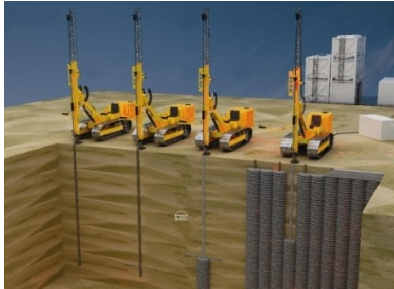
Slika 12. Mlazno injektiranje tla
