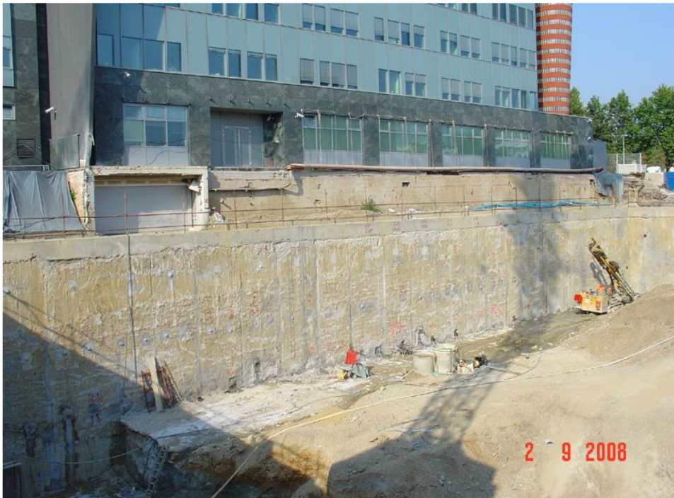
Slika 17. postojeća zgrada RBA uz samu zaštitnu konstrukciju[13]
