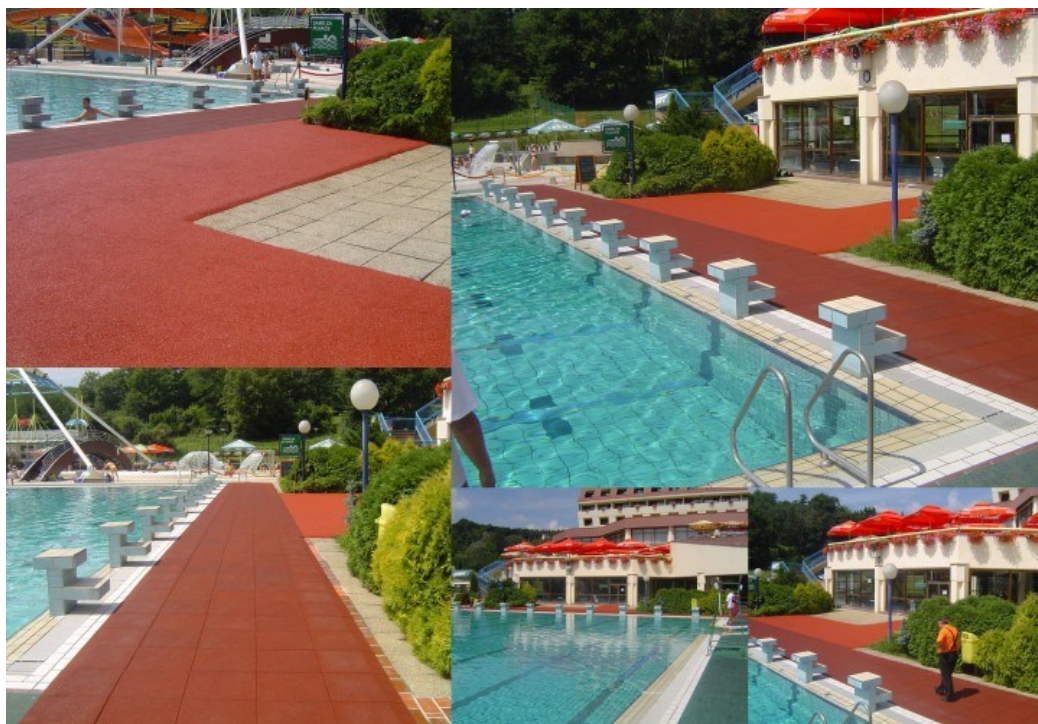
Slika 8. Reciklirane gumene podloge postavljene u svrhu zdrastva i njege [11]
