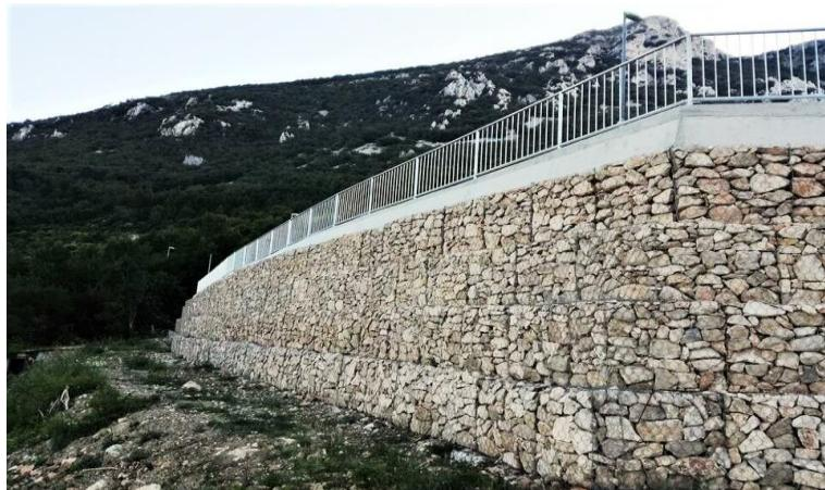
**Slika 23. Gabionski zid**
