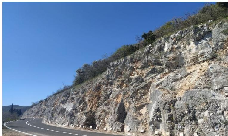
**Slika 21. Sanacija padine ugradnjom zaštitne mreže ojačane čeličnom užadi te štapnih sidara**
