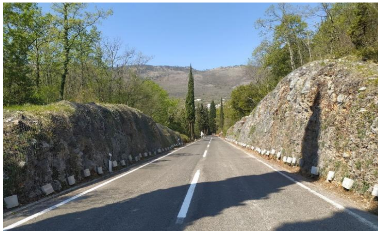
Slika 20. Prikaz izvedene zaštite postavljanjem zaštitne mreže
