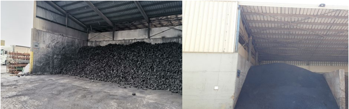
Slika 4. Skladištenje sirovina (koksa/podgranuliranog koksa) u natkrivenom dijelu
