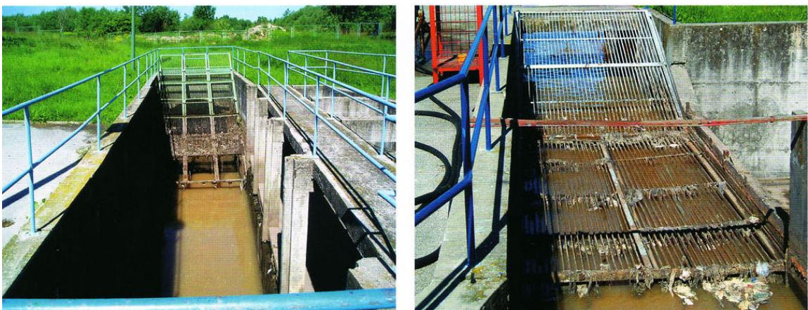
Slika 1. Grube rešetke na uređaju za pročišćivanje (Varaždin) [1]
