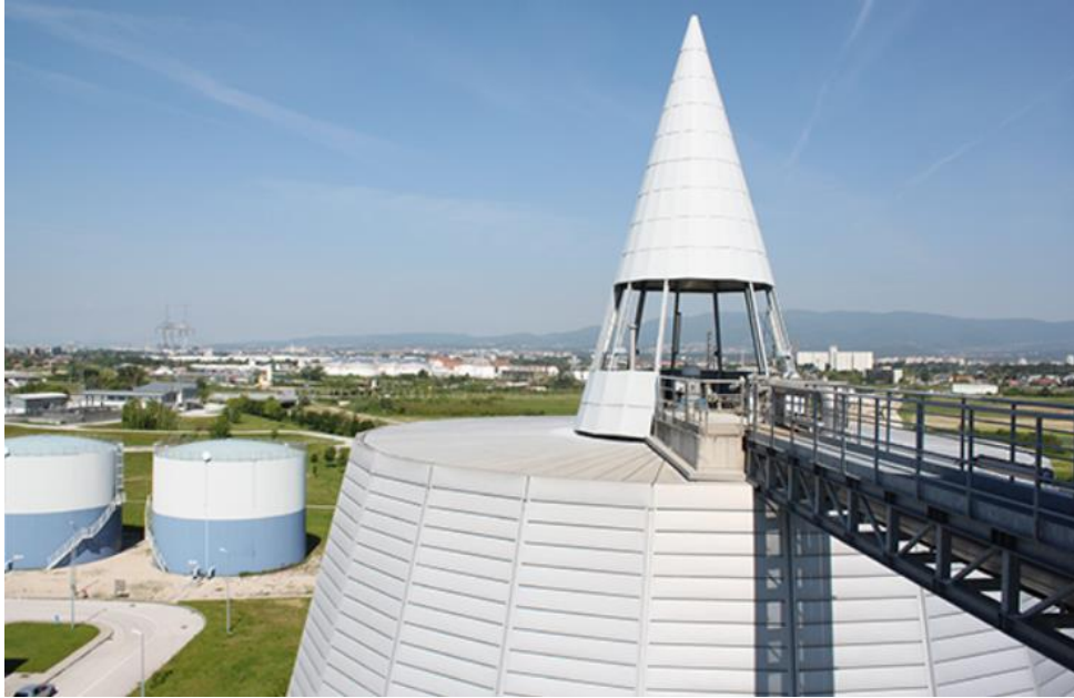
Slika 11. Vrh digestora s pogledom na grad [18]
