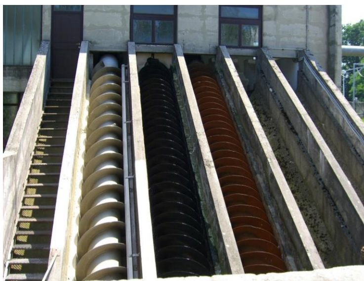
Slika 4. Pužne pumpe (primjer Bjelovar) [2]
