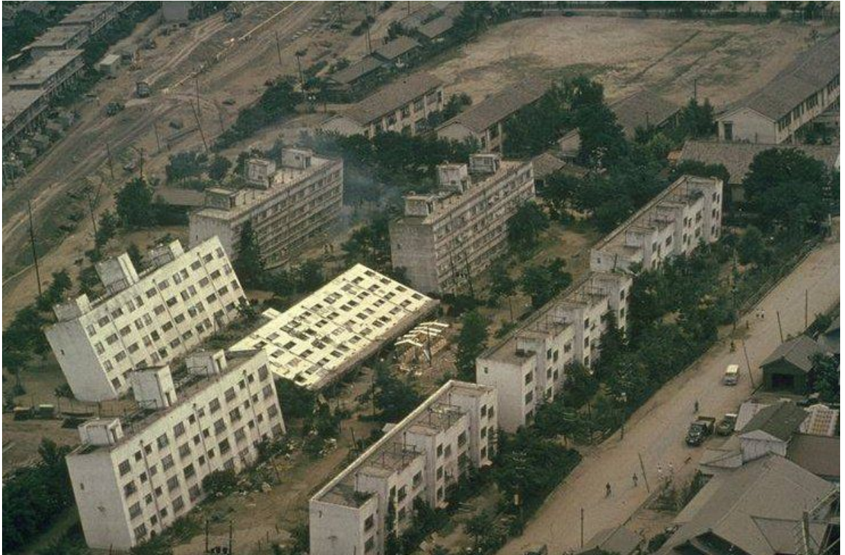
Slika 7 Prevrtnje građevina uzrokovano likvefakcijom tla (Geotech, 2019.)
