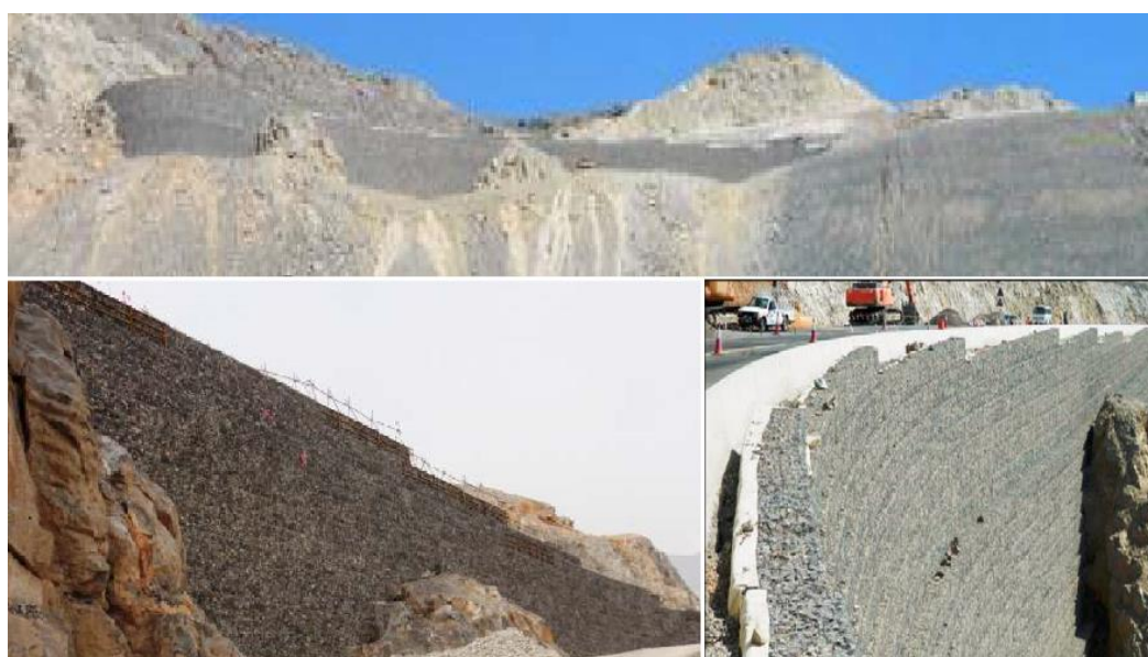
Slika 11. Potporni zid od armiranog tla visine 32 m, UAE
