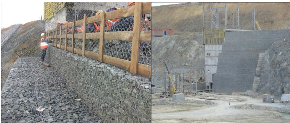
Slika 10. Potporni zid od armiranog tla visine 30 m, Rusija
