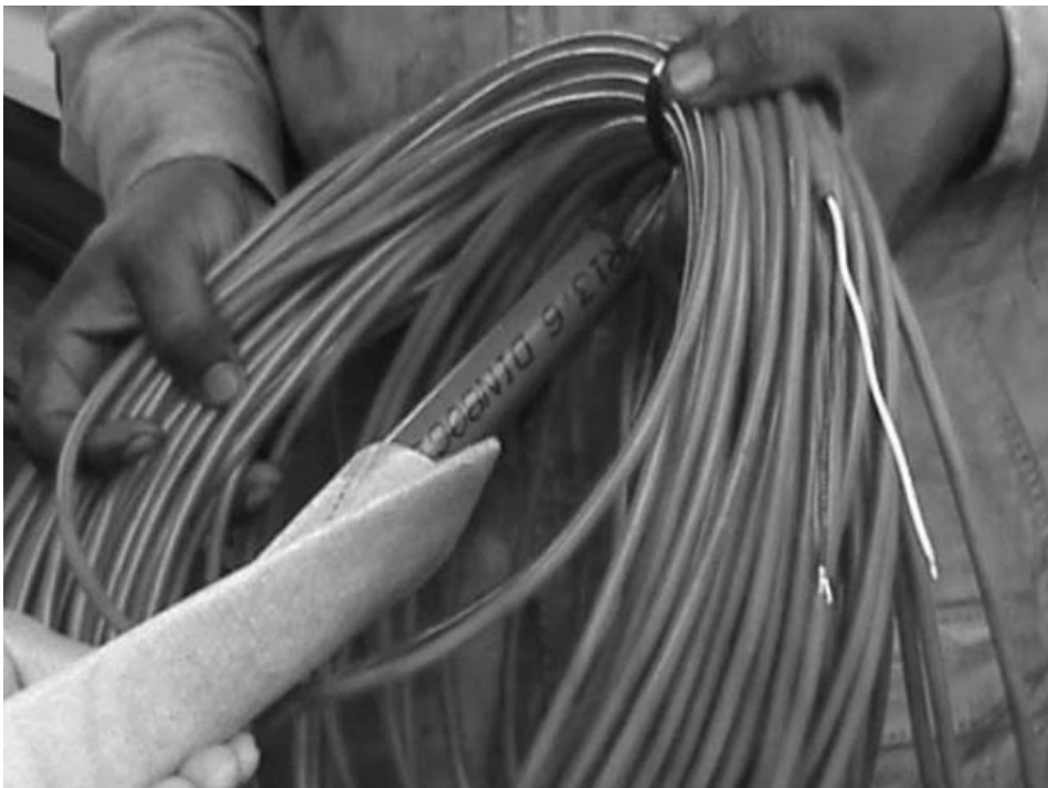
Slika 21. Ugradnja piezometra unutar PVD-a (Chu i Raju, 2003)
