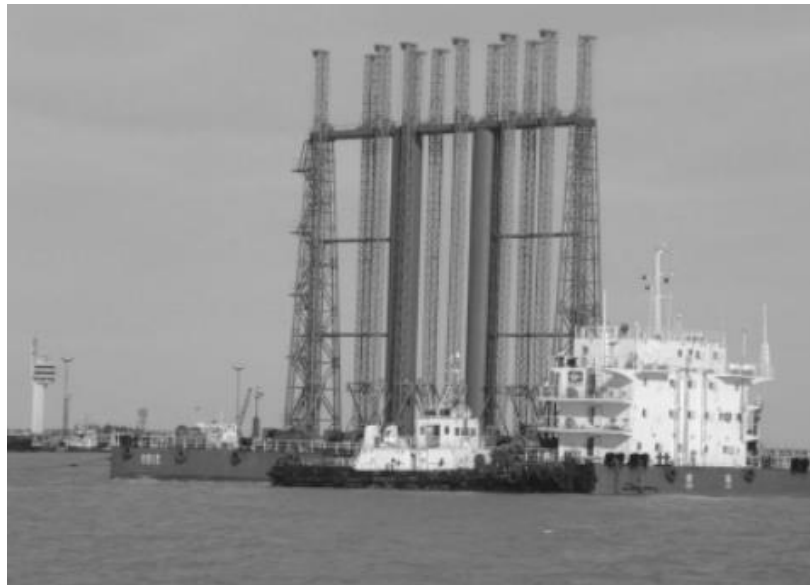
Slika 17. Teglenica opremljena za ugradnju PVD-a (Chu i sur. 2009)
