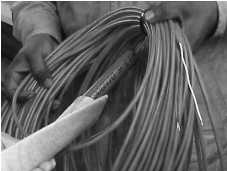
Slika 21. Ugradnja piezometra unutar PVD-a (Chu i Raju, 2003)
