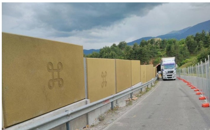
Slika 4. Ruconbar (engl. Rubberised Concrete Noise Barriers) – ekološka barijera za zaštitu od buke (Beton Lučko, 2012.)
