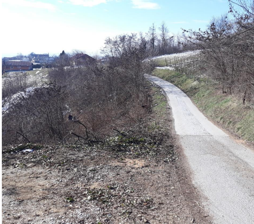
Slika 14. Prikaz lokacije klizišta
