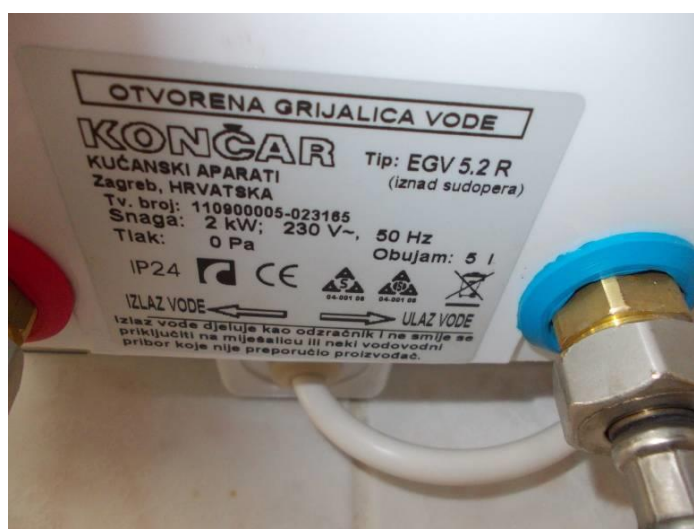
Slika 19 Natpisna pločica električnog bojlera marke Končar [15]
