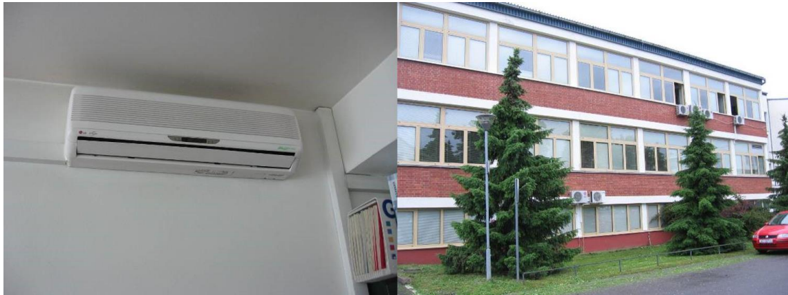
Slika 15 Rashladni uređaj, unutarnja jedinica (lijevo), vanjska jedinica (desno) [15]
