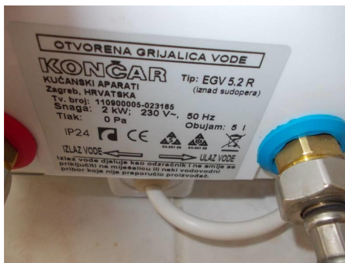
Slika 19 Natpisna pločica električnog bojlera marke Končar [15]
