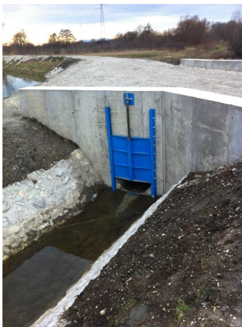
Slika 32. Zapornica na dovodnom kanalu oborinskih voda na rijeci Plitvici, 21.2.2016.
