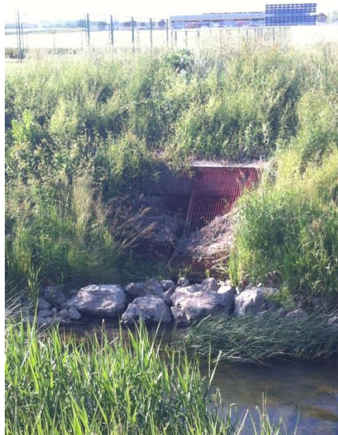
Slika 31. Mjesto ispuštanja oborinske otpadne vode u rijeku Plitvicu, 22.5.2016. [2]
