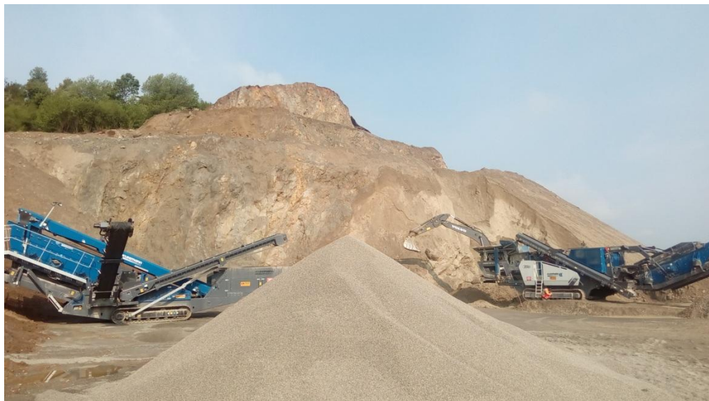
Slika 8. Jugoistočni dio kamenoloma s formiranim etažama
