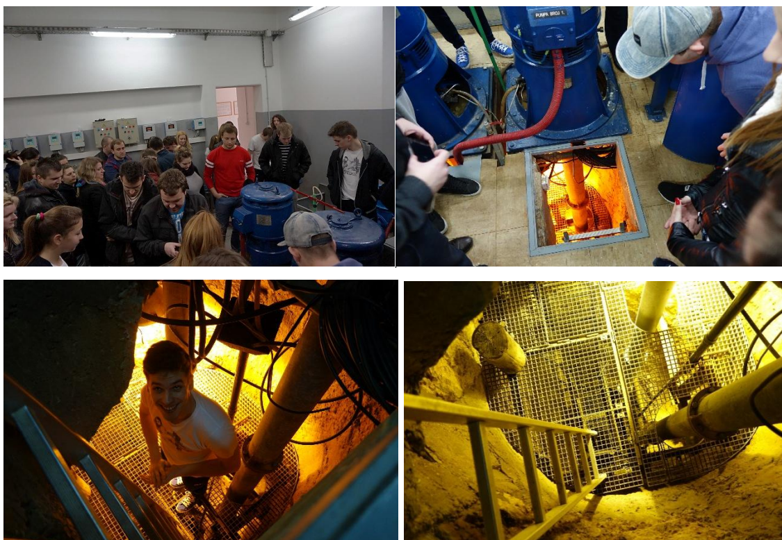
Slika 5. Kontrolna soba (gore) s pogledom na unutrašnjost zdenca Jadreški (dolje).
