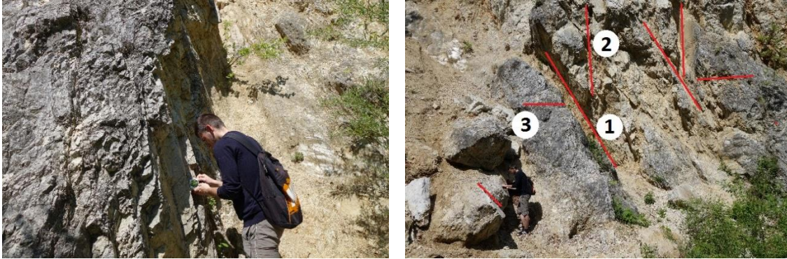
Slika 22. Detalji s prve lokacije s naznačenim glavnim familijama diskontinuiteta
