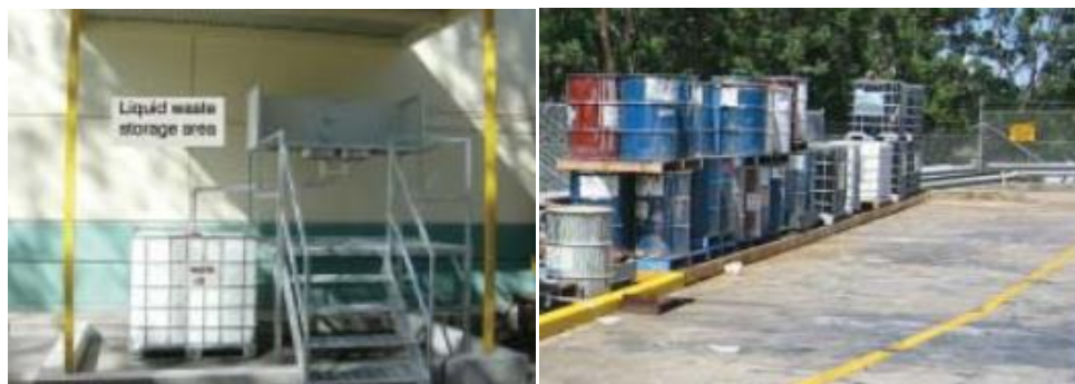
Slika 31. Primjer dobrog (lijevo) i lošeg skladištenja tekućeg otpada (desno) [38]
