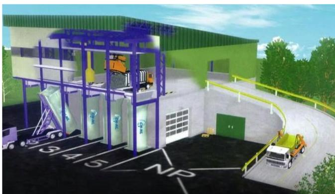
Slika 28. Vertikalni način izvedbe pretovarne stanice [35]
