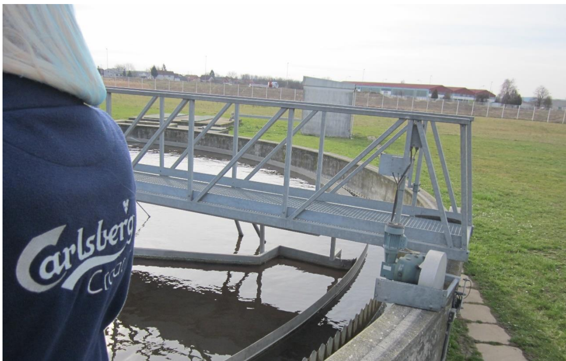
Slika 16. Taložni tank
