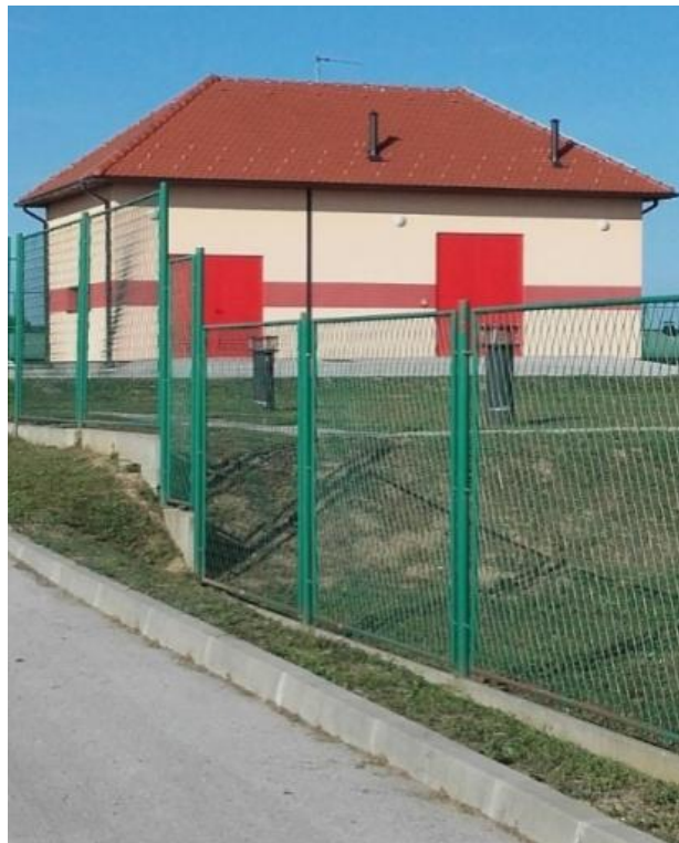
Slika 22. Precrpna stanica Kućan [2]
