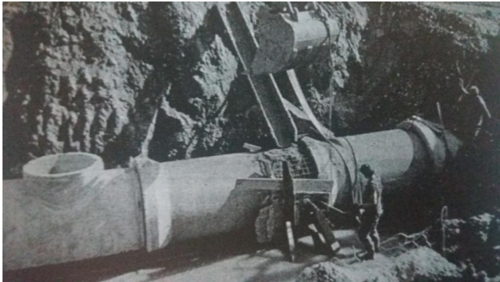
Slika 19. Sjeverni gradski kolektor [2]
