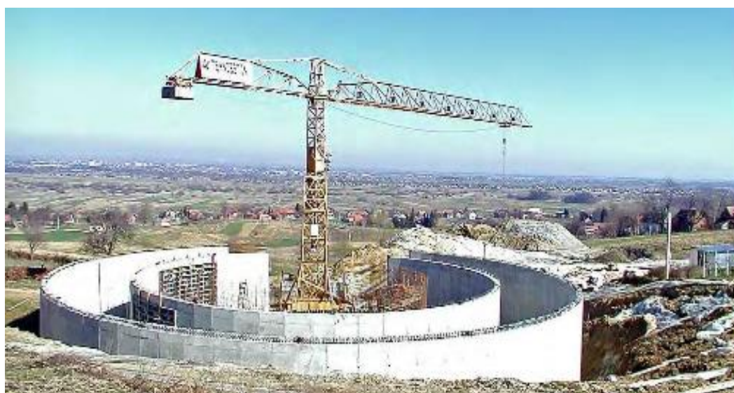
Slika 20. Izgradnja prve komore vodospreme Doljan volumena 5.000 m 3 , 2002.godine [11]
