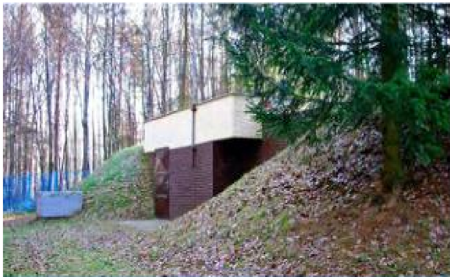
Slika 21 : Vodosprema Lužan volumena 400 m 3 [11]
