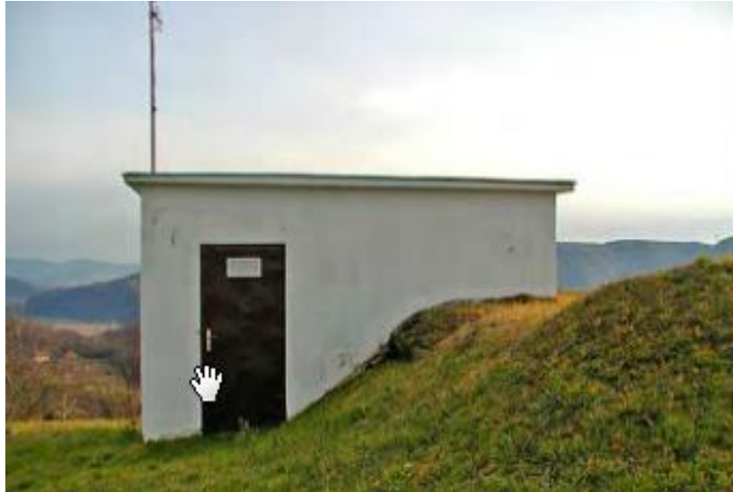
Slika 22. Vodosprema Briška volumena 500 m 3 [11]
