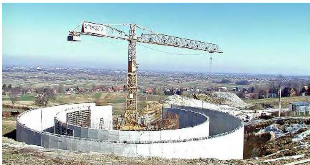
Slika 20. Izgradnja prve komore vodospreme Doljan volumena  $5.000 \text{ m}^3$ ,
