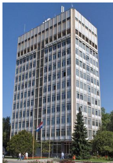
Slika 8. Zgrada vodotornja u Varaždinu [14]
