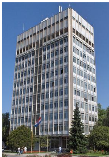
Slika 8. Zgrada vodotornja u Varaždinu [14]
