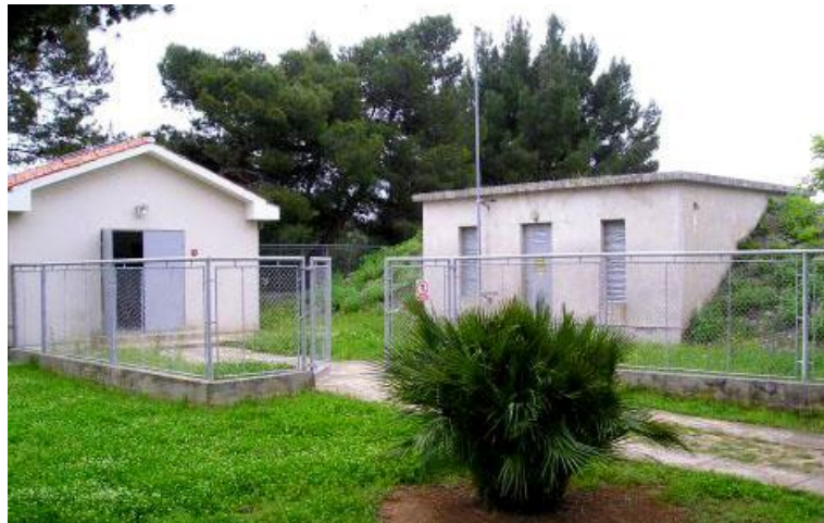
Slika 7. Vodosprema Kalvarija, otok Mali Lošinj [13]
