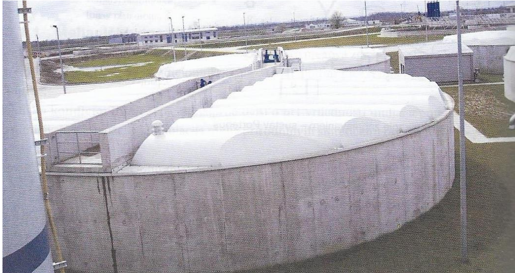
Slika 7. Pokriveni gravitacijski zgušnjivač mulja na uređaju za pročišćavanje u Zagrebu [3]
