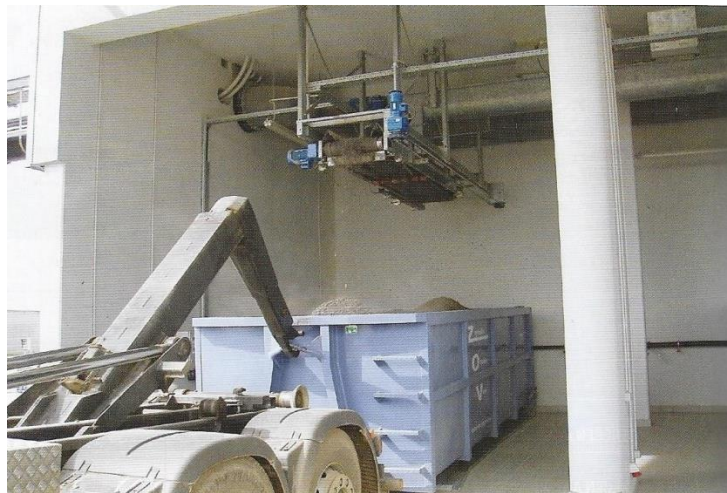
Slika 11. Stabilizacija vapnom na uređaju za pročišćavanje u Zagrebu [3]
