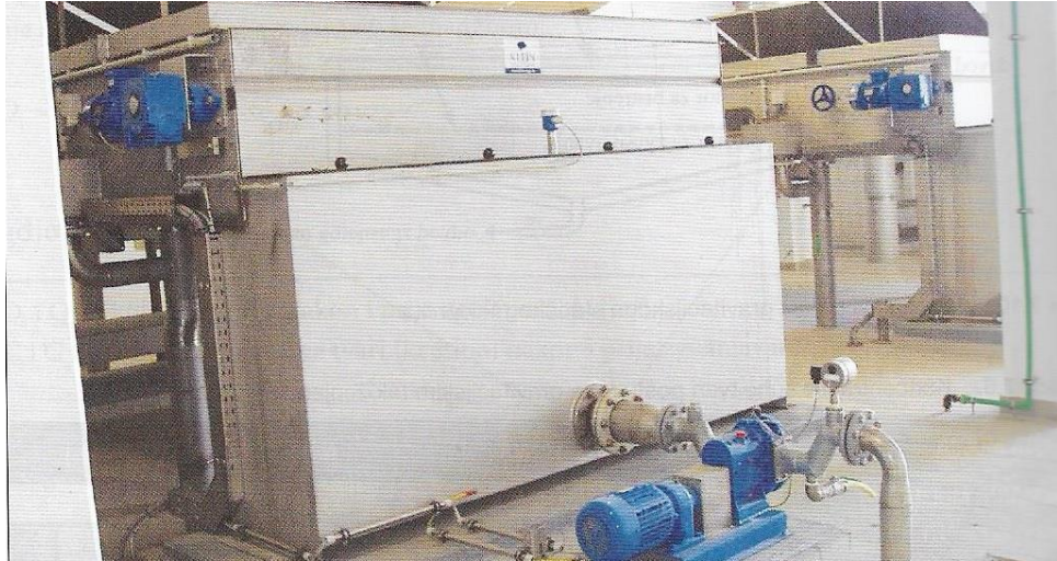
Slika 8. Dinamičko zgušnjavanje mulja na uređaju za pročišćavanje u Zagrebu [3]
