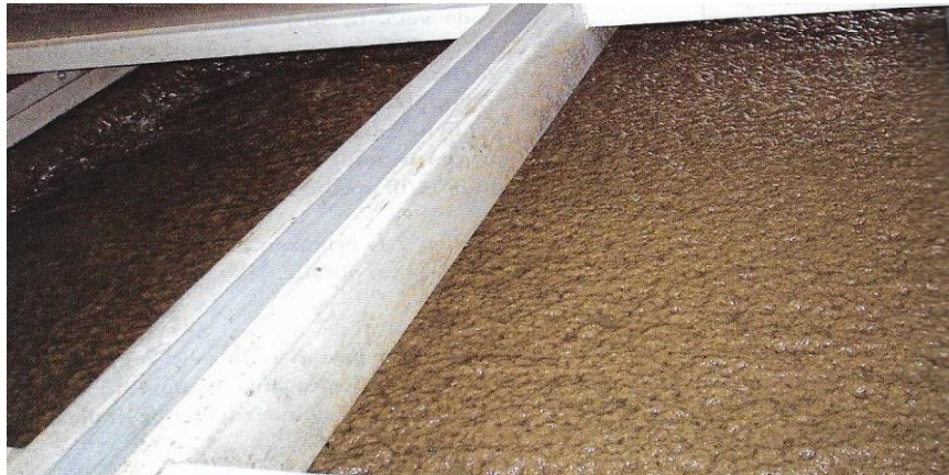
Slika 6. Sirovi mulj na uređaju za pročišćavanje otpadne vode grada Zagreba [3]
