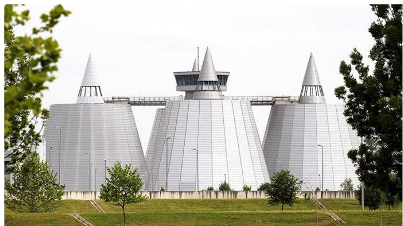
Slika 10. Tornjevi anaerobne obrade mulja na uređaju za pročišćavanje u Zagrebu [14]
