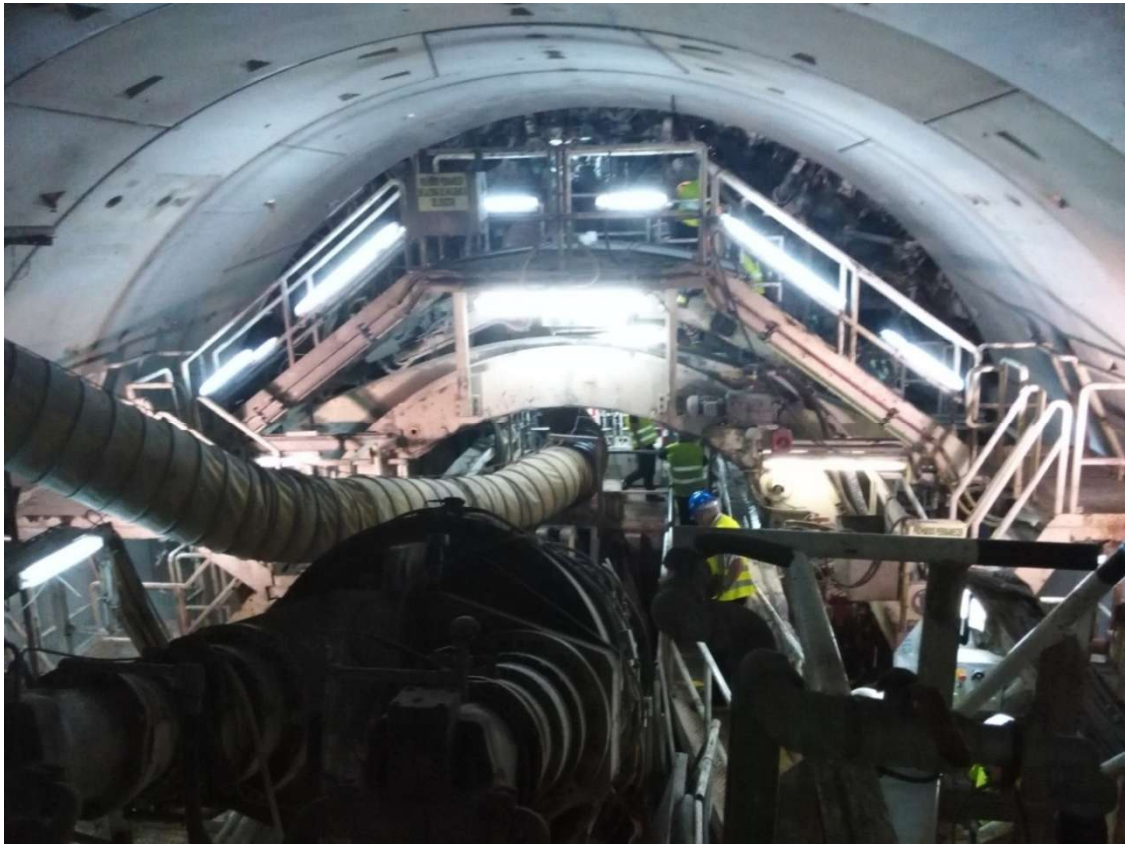
Slika 11. Strojni iskop tunela (TBM)
