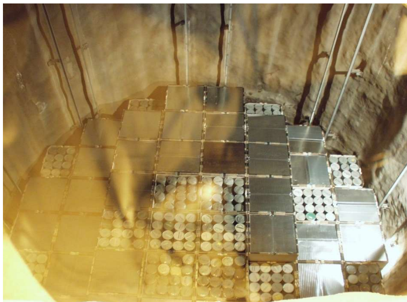
Slika 18. Pogled usilos s odloženim RAO u odlagalištu Olkiluoto, Finska [1]
