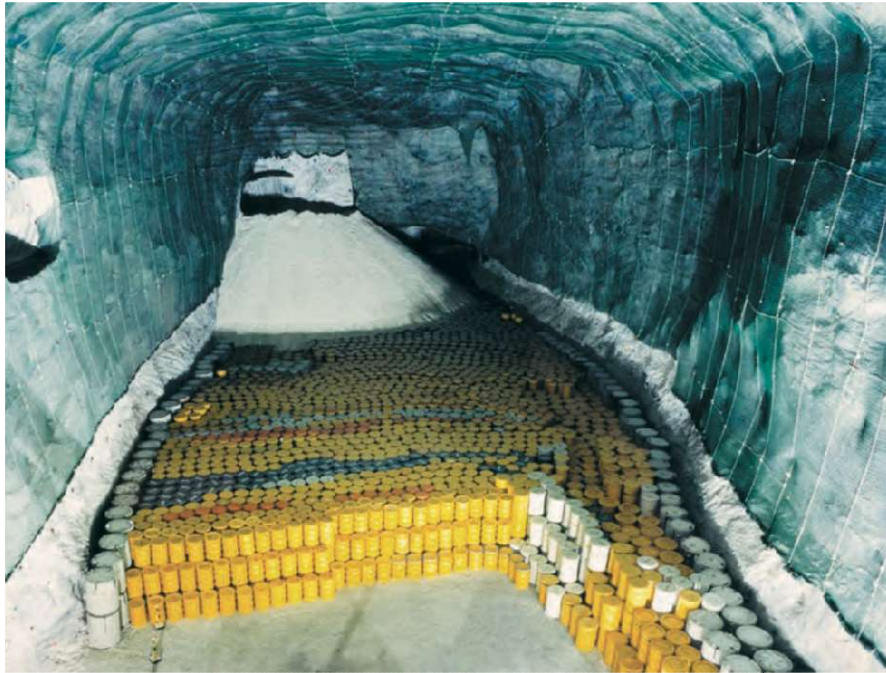
Slika 22. Duboko podzemno odlagalište za NRAO i SRAO u nekadašnjem rudniku kamene soli u Morslebenu, Njemačka [18]
