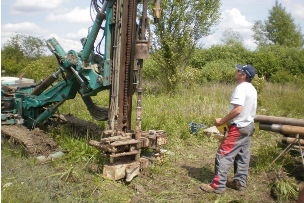
Slika 13. Prikaz istražnog bušenja sa jezgrovanjem [17]
