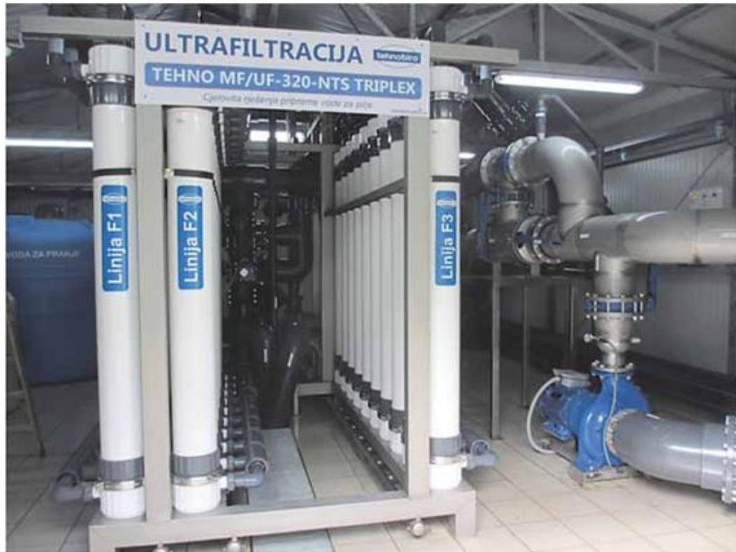
Slika 2 Membranski proces ultrafiltracije
