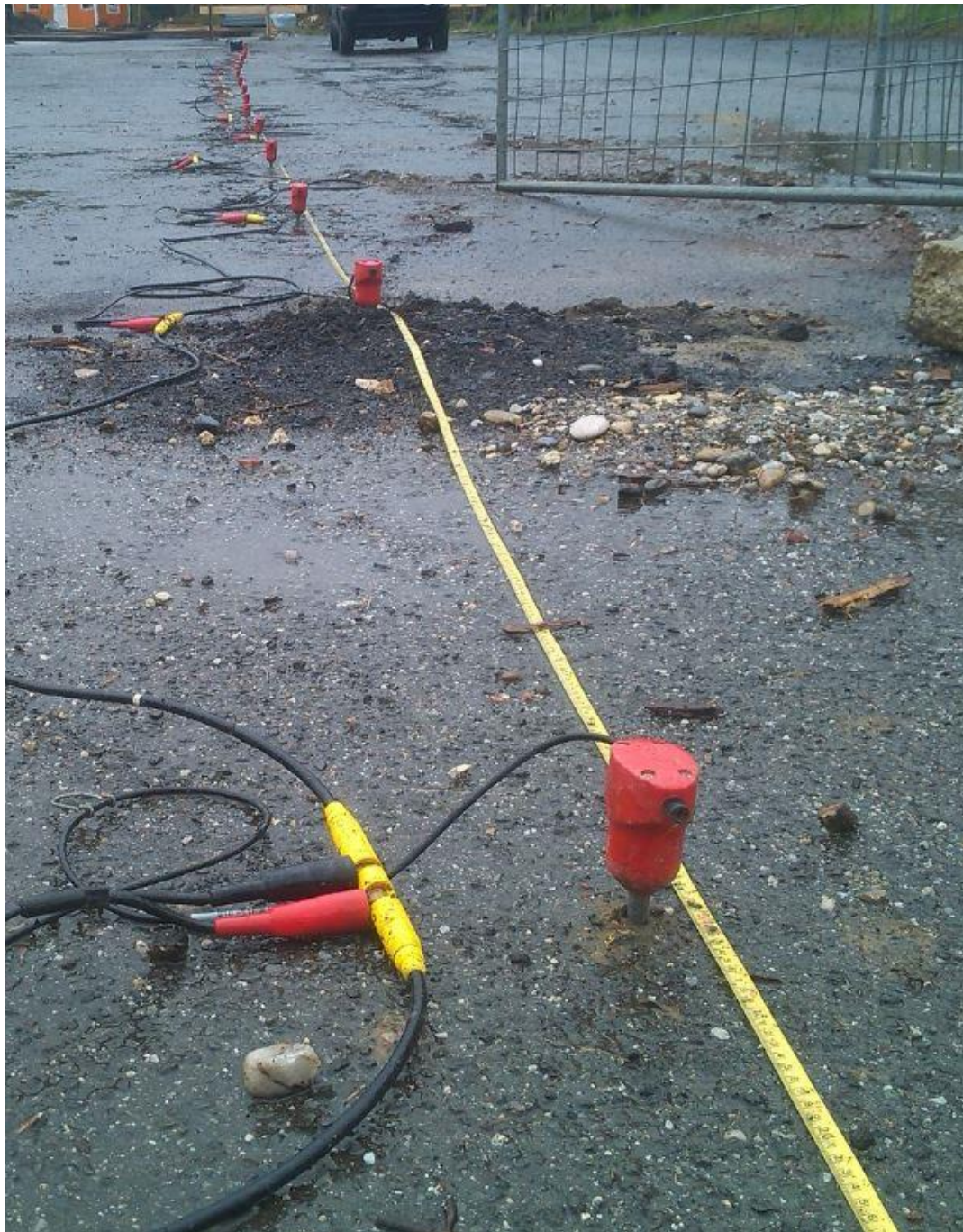
Slika 27. Geofonski postav na terenu (profil MASW 1-prije)
