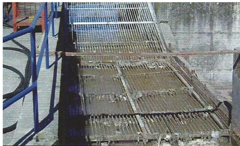
**Slika 2.** Grube rešetke na uređaju za pročišćavanje otpadnih voda
