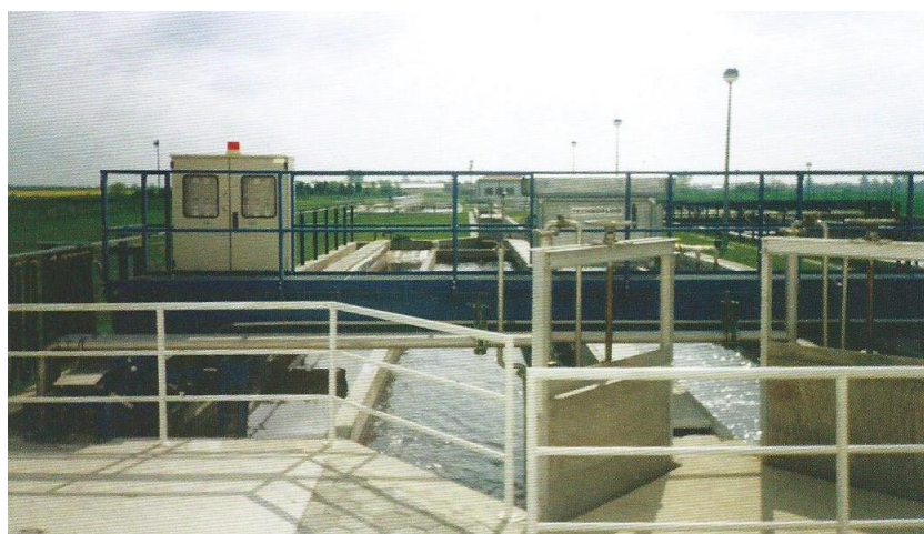
Slika 8. Prozračeni pjeskolov – mastolov na uređaju u Čakovcu
