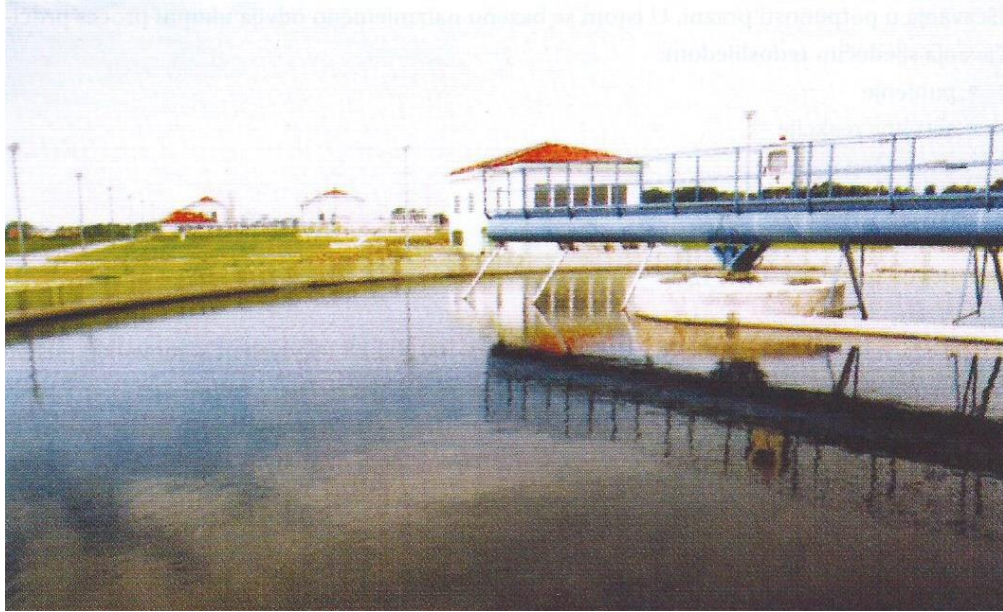
Slika 11. Naknadni taložnik na uređaju u Čakovcu
