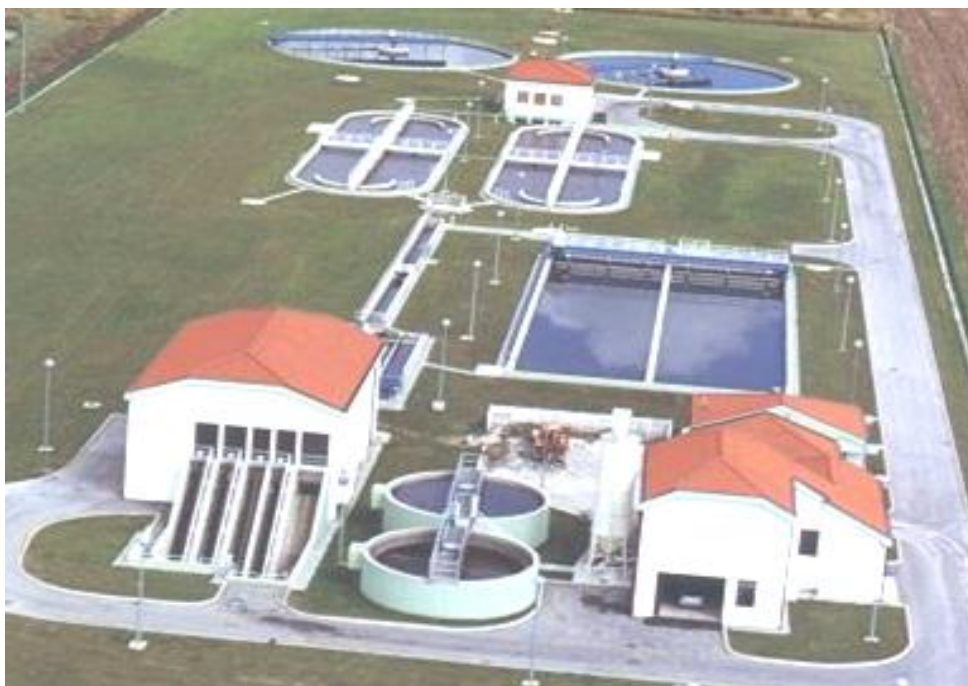
Slika 1. Uređaj za pročišćavanje otpadnih voda u Čakovcu
