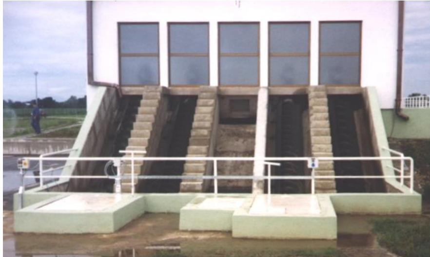
Slika 10. Crpilište biljnog mulja
