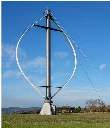
Slika 22. Darrieusova vjetroturbina [24].
