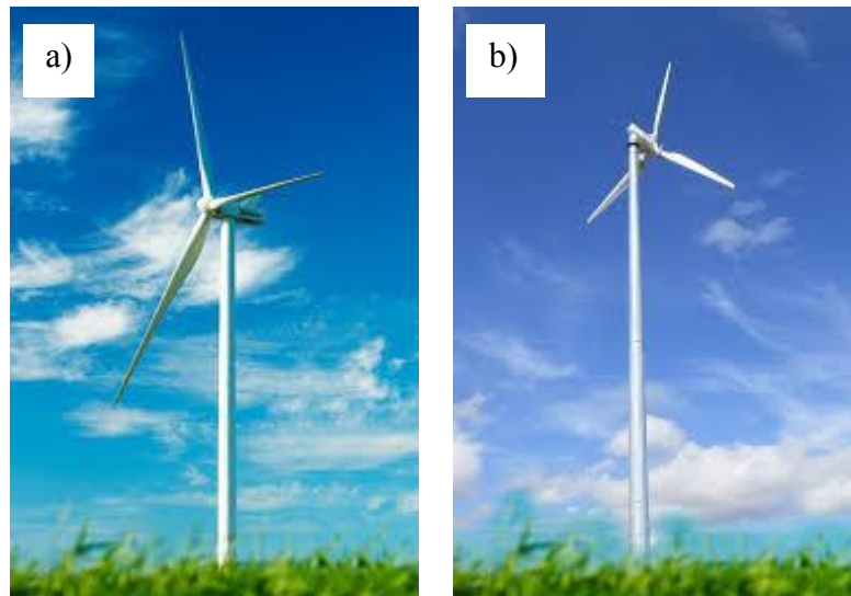
Slika 18. a) Izvedba sa stupom iza lopatica i b) izvedba sa stupom ispred lopatica [22].
