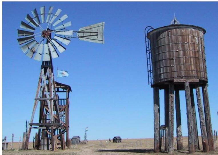
Slika 26. Upotreba malih vjetroturbina za crpljenje vode [28].
