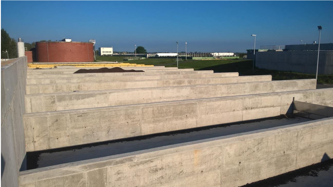
Slika 3.3 Prikaz kompostane smještene uz UPOV-a Grada Varaždina
